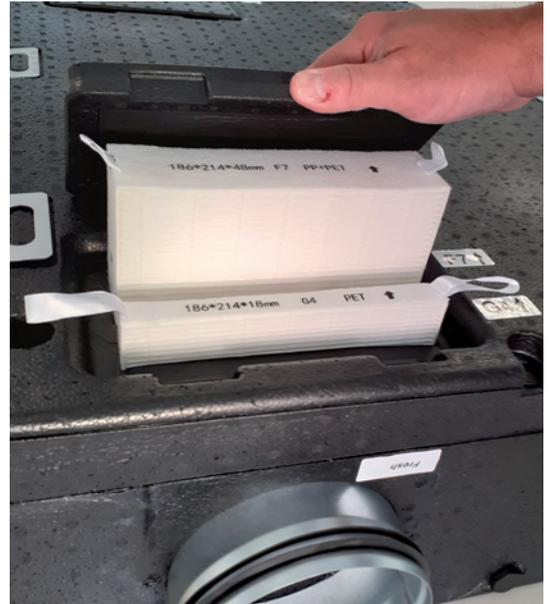
Accès aux filtres par le dessous, pas besoin d'ouvrir la Double flux pour assurer l'entretien des filtres.
